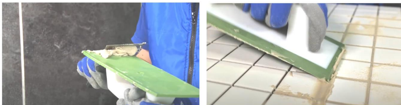
Рис. 31. Заполнение швов затиркой при помощи резинового шпателя
