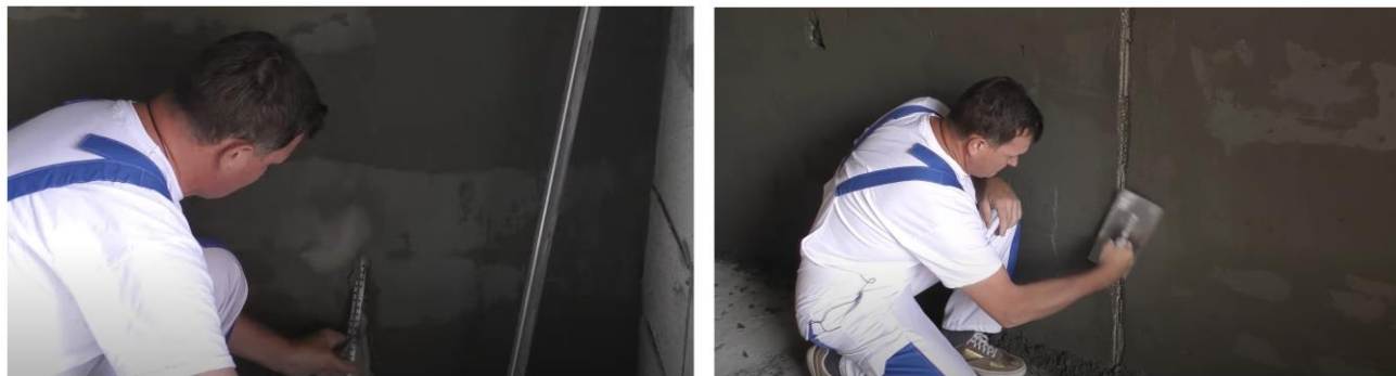
Рис. 24. Схема демонтажа маяков и заделки образовавшихся борозд
