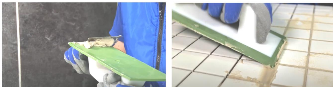
Рис. 38. Заполнение швов затиркой при помощи резинового шпателя
