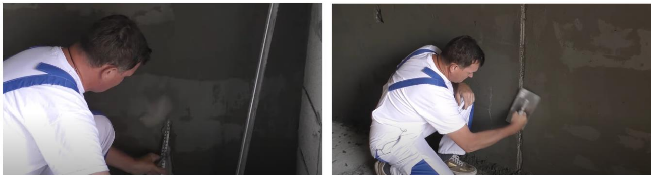
Рис. 28. Схема демонтажа маяков и заделки образовавшихся борозд
