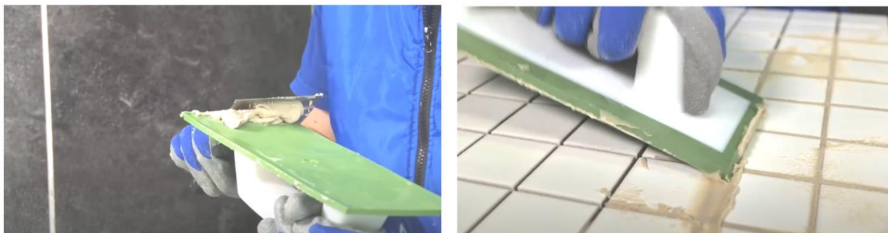
Рис. 37. Заполнение швов затиркой при помощи резинового шпателя
