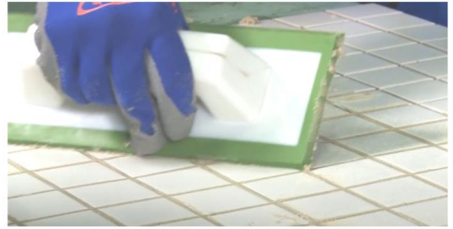
Рис. 38. Диагональными движениями шпателя убрать с поверхности плитки излишки затирки
