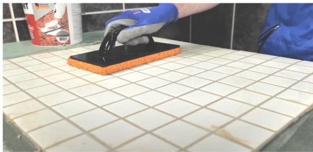
Рис. 39. Диагональными движениями шпателя убрать с поверхности плитки излишки затирки
