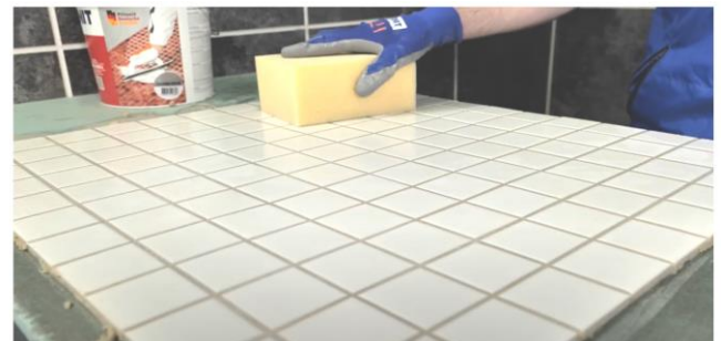
Рис. 39. Диагональными движениями шпателя убрать с поверхности плитки излишки затирки
