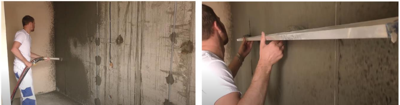
Рис. 28. Схема нанесения обрызга на поверхность и разравнивание правилами образовавшихся наплывов
