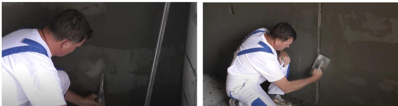
Рис. 33. Схема демонтажа маяков и заделки образовавшихся борозд
