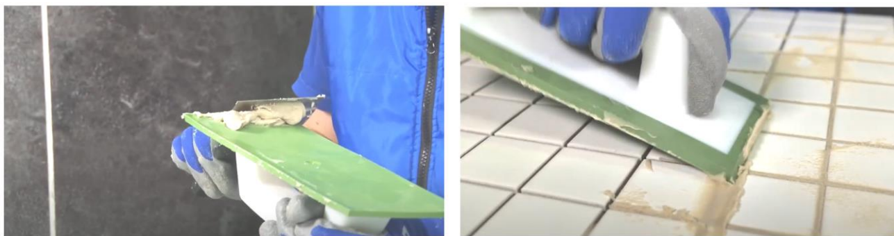
Рис. 39. Заполнение швов затиркой при помощи резинового шпателя
