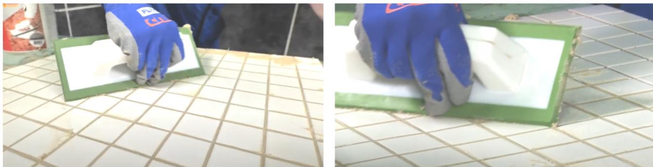
Рис. 40. Диагональными движениями шпателя убрать с поверхности плитки излишки затирки
