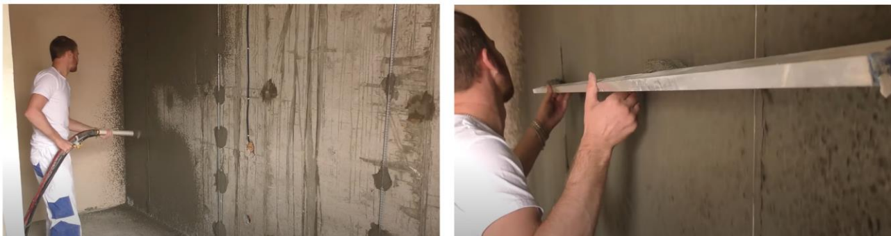
Рис. 30. Схема нанесения обрызга на поверхность и разравнивание правилами образовавшихся наплывов
