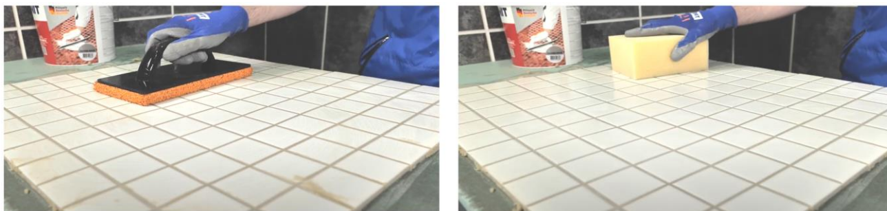
Рис. 40. Диагональными движениями шпателя убрать с поверхности плитки излишки затирки
