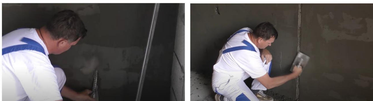
Рис. 24. Схема демонтажа маяков и заделки образовавшихся борозд
