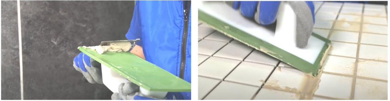
Рис. 38. Заполнение швов затиркой при помощи резинового шпателя
