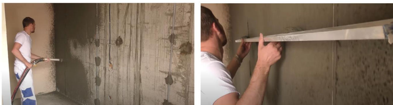
Рис. 27. Схема нанесения обрызга на поверхность и разравнивание правилами образовавшихся наплывов
