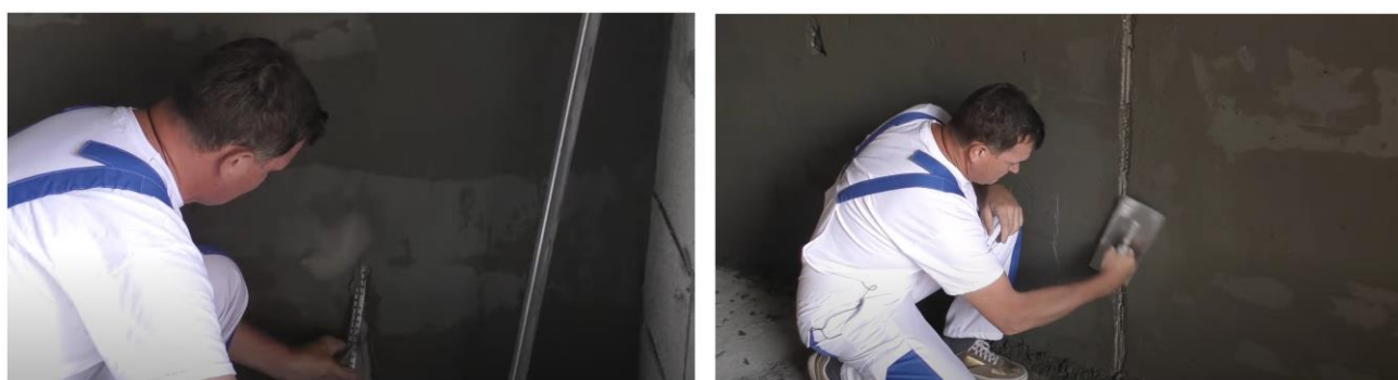
Рис. 27. Схема демонтажа маяков и заделки образовавшихся борозд
