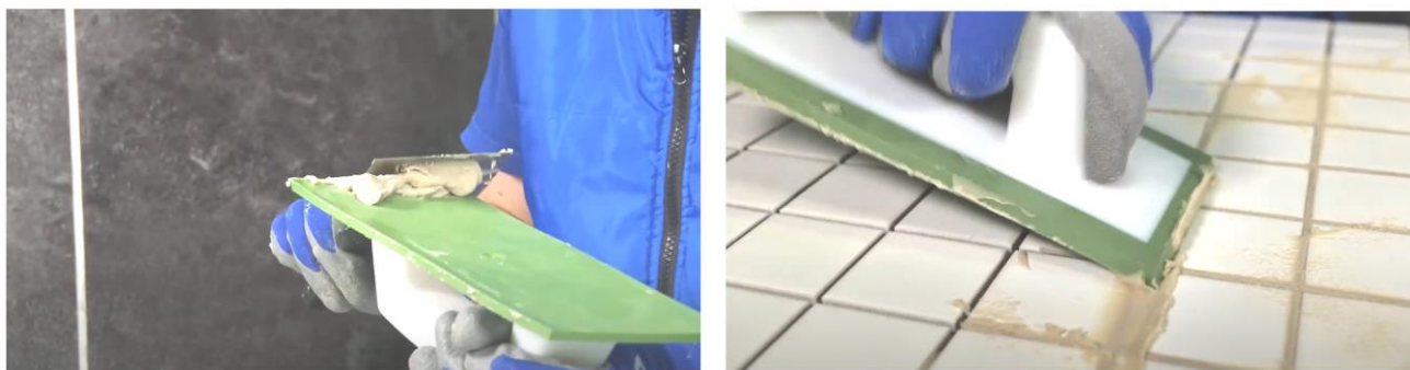
Рис. 21. Заполнение швов затиркой при помощи резинового шпателя
