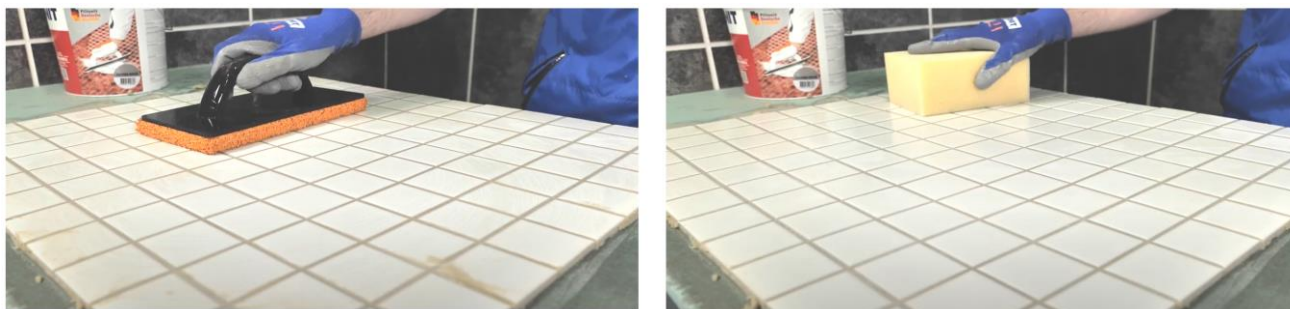
Рис. 23. Диагональными движениями шпателя убрать с поверхности плитки излишки затирки
