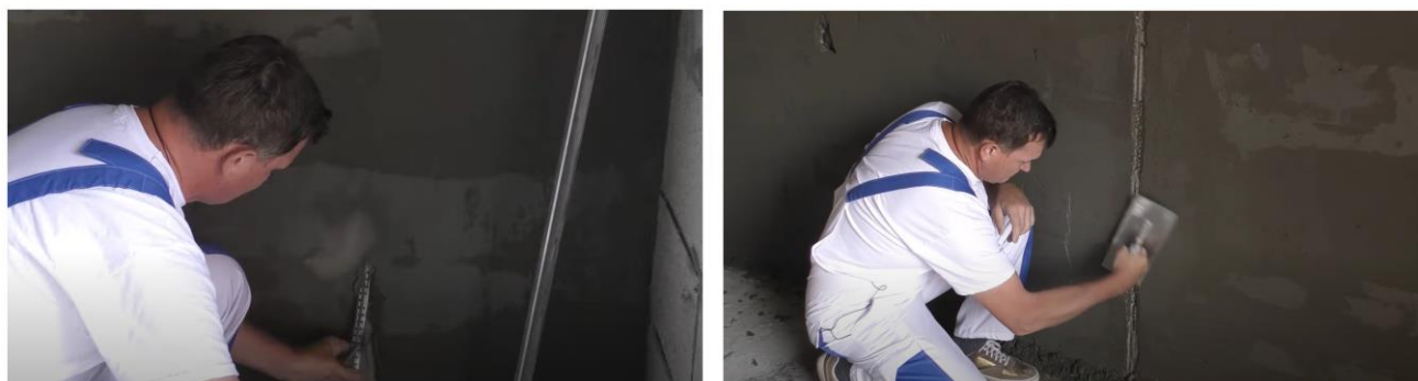
Рис. 19. Схема демонтажа маяков и заделки образовавшихся борозд
