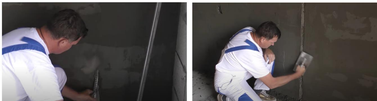
Рис. 33. Схема демонтажа маяков и заделки образовавшихся борозд
