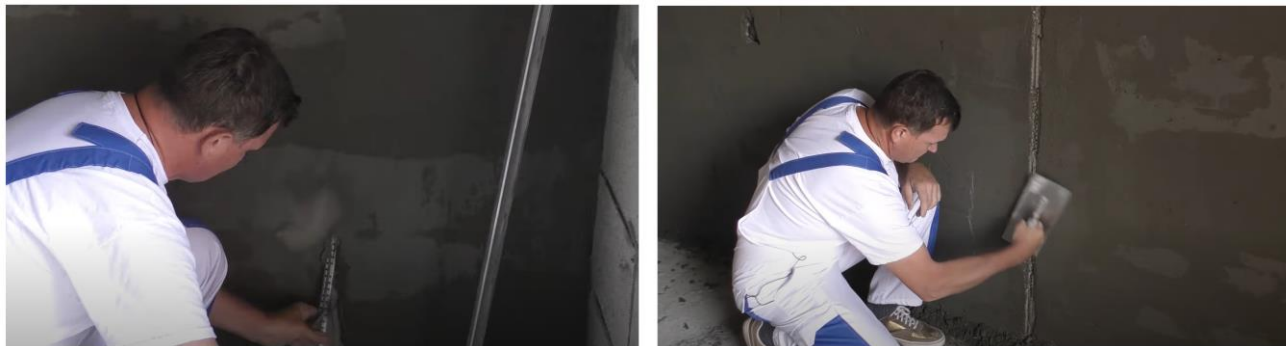
Рис. 27. Схема демонтажа маяков и заделки образовавшихся борозд
