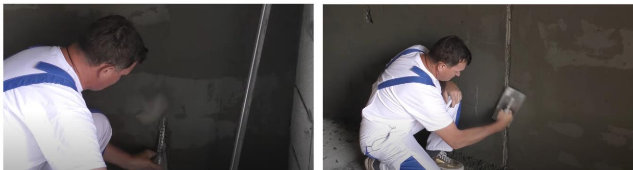
Рис. 29. Схема демонтажа маяков и заделки образовавшихся борозд
