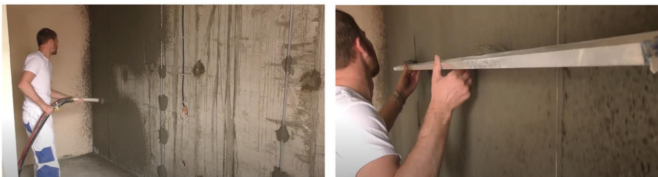
Рис. 30. Схема нанесения обрызга на поверхность и разравнивание правилами образовавшихся наплывов
