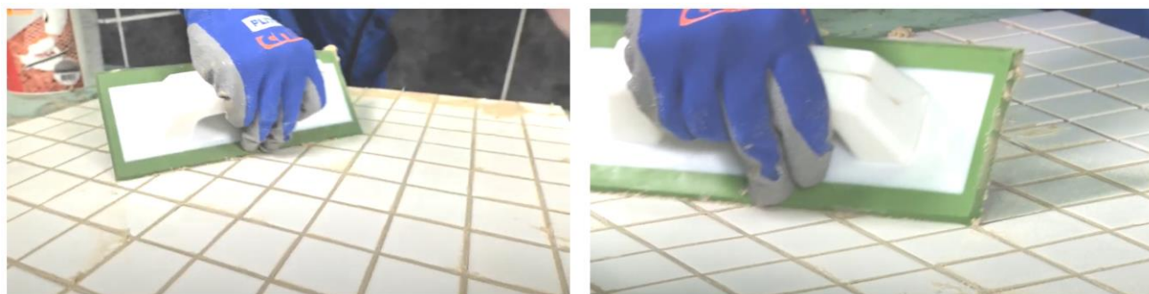
Рис. 28. Диагональными движениями шпателя убрать с поверхности плитки излишки затирки
