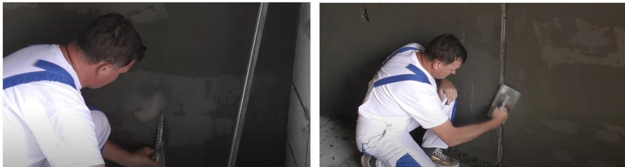
Рис. 24. Схема демонтажа маяков и заделки образовавшихся борозд
