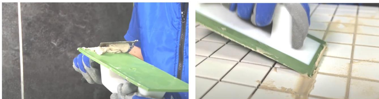
Рис. 23. Заполнение швов затиркой при помощи резинового шпателя
