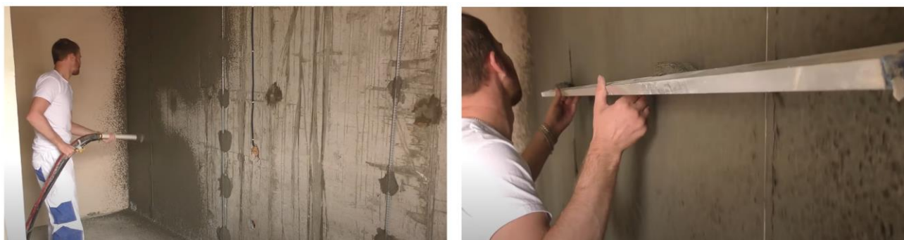
Рис. 17. Схема нанесения обрызга на поверхность и разравнивание правилами образовавшихся наплывов
