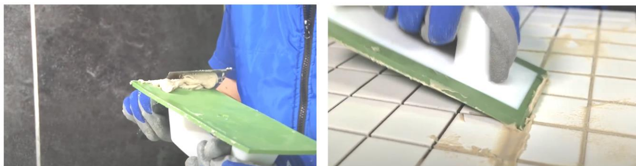
Рис. 32. Заполнение швов затиркой при помощи резинового шпателя
