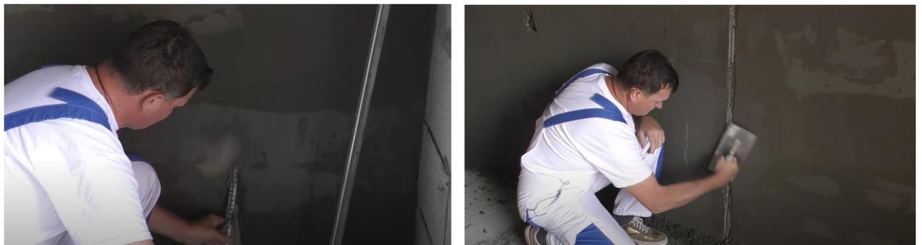
Рис. 23. Схема демонтажа маяков и заделки образовавшихся борозд
