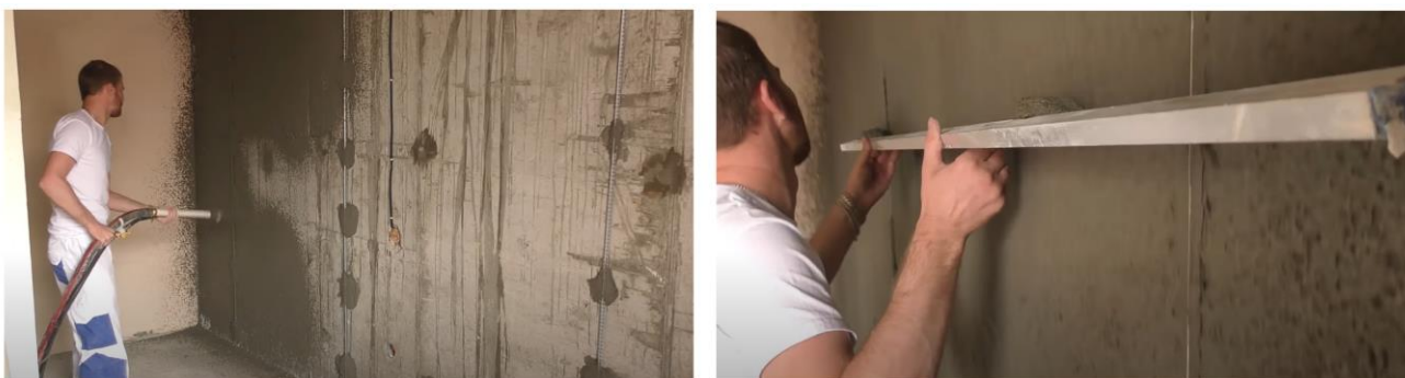
Рис. 21. Схема нанесения обрызга на поверхность и разравнивание правилами образовавшихся наплывов
