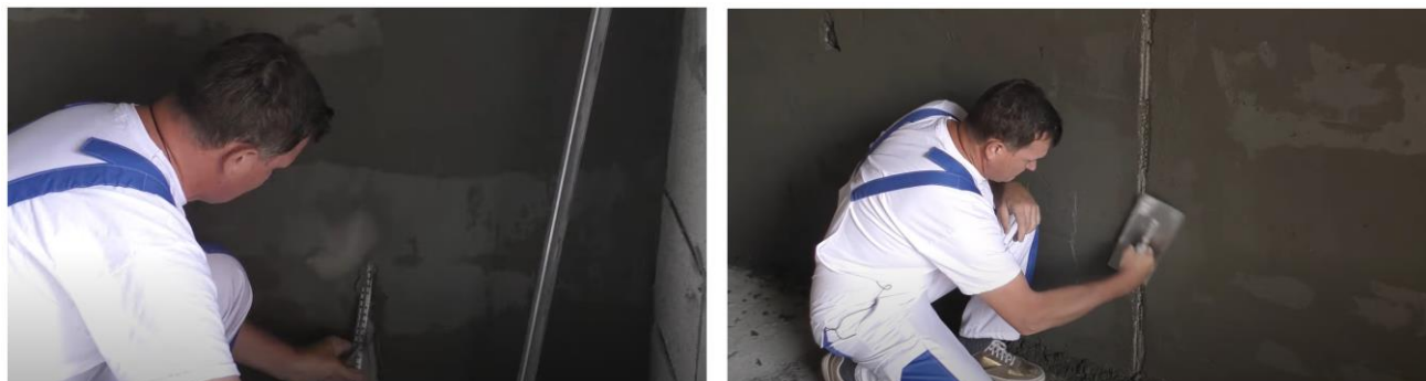
Рис. 33. Схема демонтажа маяков и заделки образовавшихся борозд
