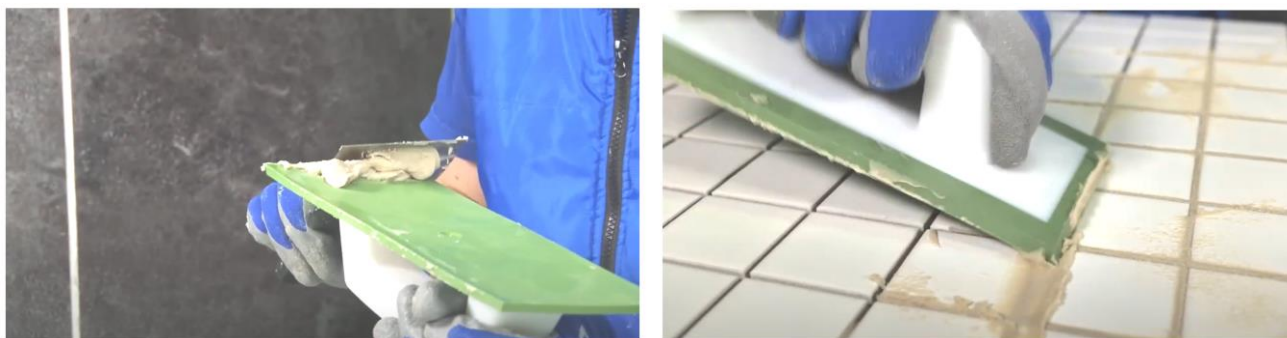
Рис. 25. Заполнение швов затиркой при помощи резинового шпателя
