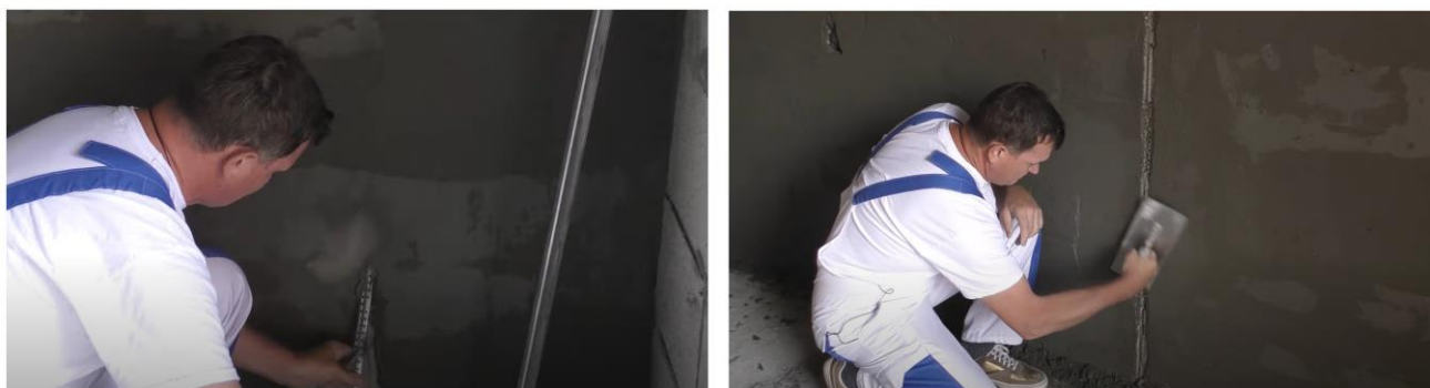
Рис. 24. Схема демонтажа маяков и заделки образовавшихся борозд
