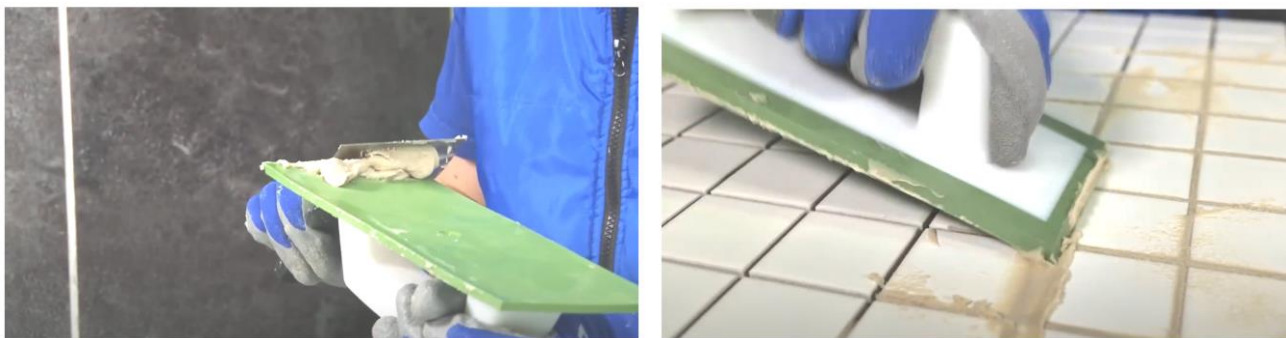
Рис. 17. Заполнение швов затиркой при помощи резинового шпателя
