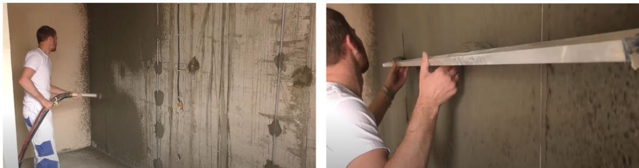
Рис. 22. Схема нанесения обрызга на поверхность и разравнивание правилами образовавшихся наплывов
