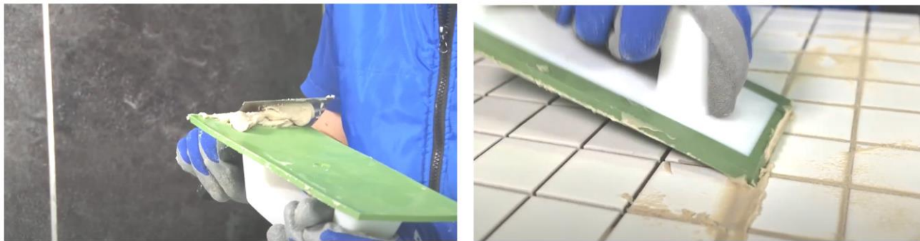
Рис. 38. Заполнение швов затиркой при помощи резинового шпателя
