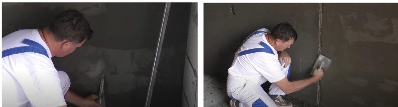
Рис. 28. Схема демонтажа маяков и заделки образовавшихся борозд
