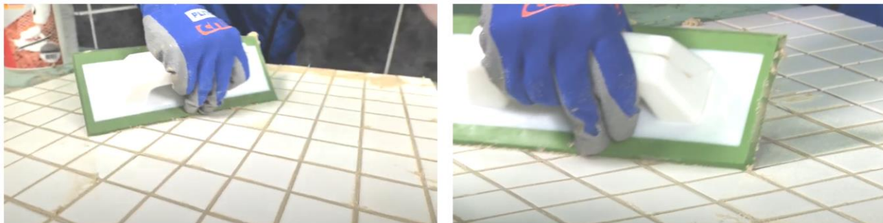
Рис. 35. Диагональными движениями шпателя убрать с поверхности плитки излишки затирки
