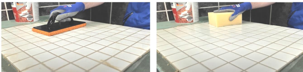
Рис. 36. Диагональными движениями шпателя убрать с поверхности плитки излишки затирки
