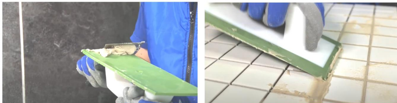
Рис. 34. Заполнение швов затиркой при помощи резинового шпателя
