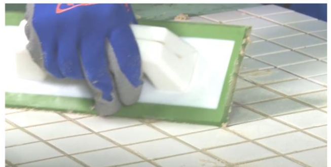
Рис. 24. Диагональными движениями шпателя убрать с поверхности плитки излишки затирки
