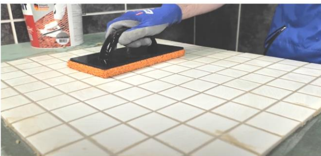
Рис. 25. Диагональными движениями шпателя убрать с поверхности плитки излишки затирки
