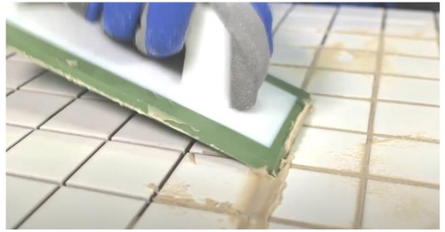
Рис. 23. Заполнение швов затиркой при помощи резинового шпателя
