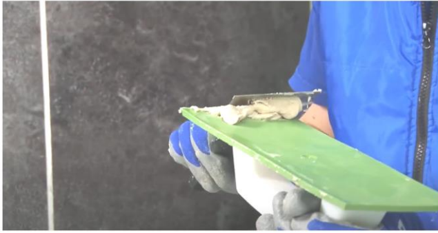
Рис. 23. Заполнение швов затиркой при помощи резинового шпателя
