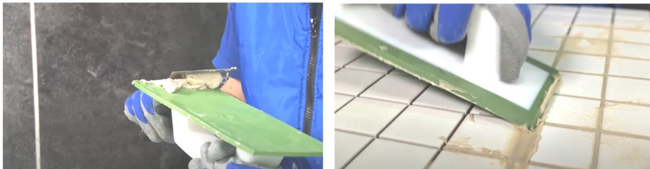
Рис. 30. Заполнение швов затиркой при помощи резинового шпателя
