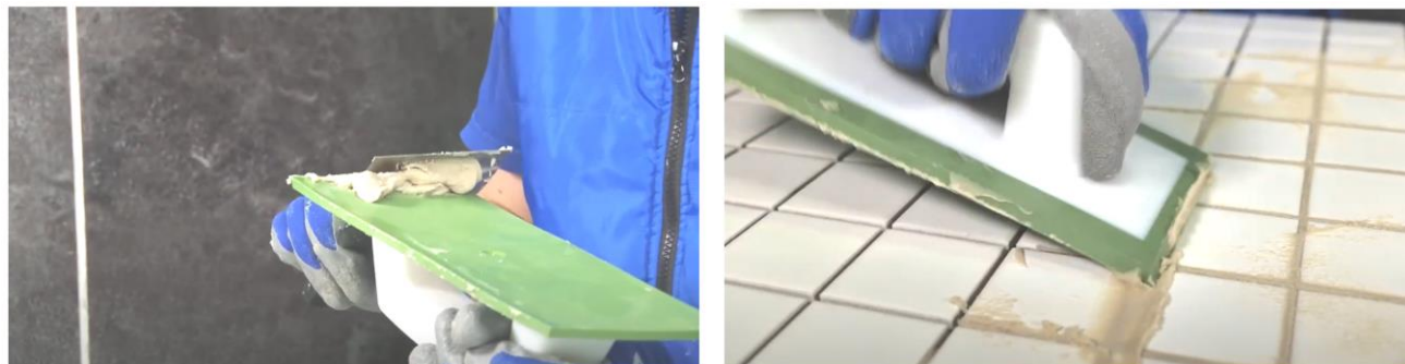
Рис. 14. Заполнение швов затиркой при помощи резинового шпателя
