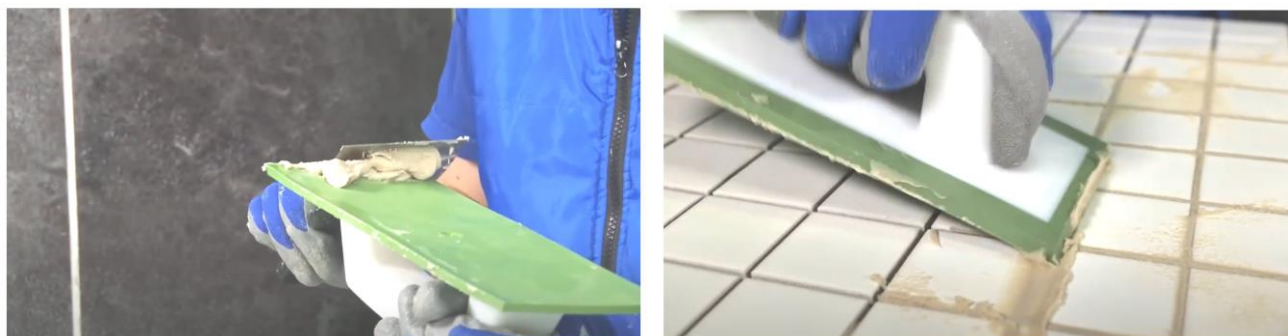
Рис. 26. Заполнение швов затиркой при помощи резинового шпателя
