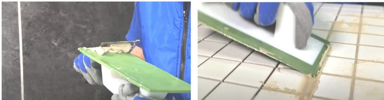
Рис. 18. Заполнение швов затиркой при помощи резинового шпателя
