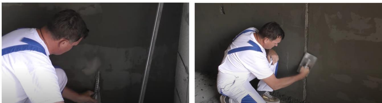
Рис. 27. Схема демонтажа маяков и заделки образовавшихся борозд
