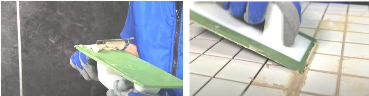
Рис. 35. Заполнение швов затиркой при помощи резинового шпателя
