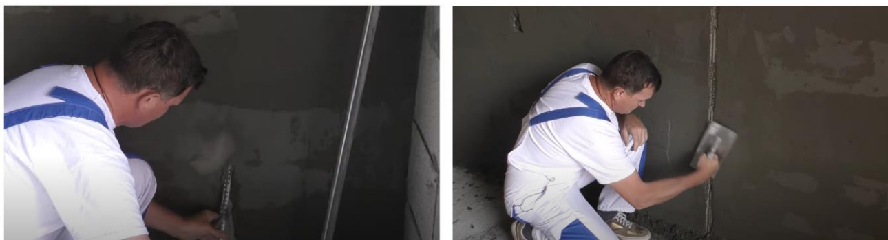
Рис. 33. Схема демонтажа маяков и заделки образовавшихся борозд
