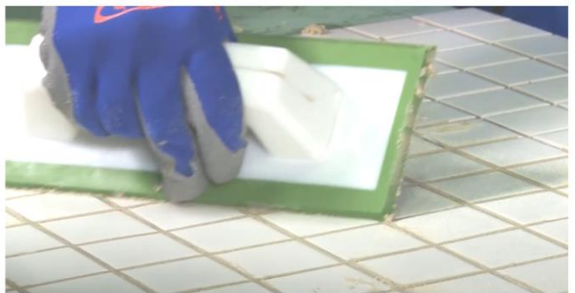
Рис. 26. Диагональными движениями шпателя убрать с поверхности плитки излишки затирки
