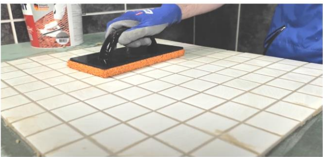
Рис. 27. Диагональными движениями шпателя убрать с поверхности плитки излишки затирки
