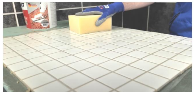
Рис. 27. Диагональными движениями шпателя убрать с поверхности плитки излишки затирки
