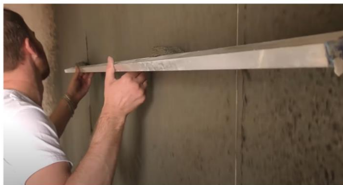
Рис. 9. Схема нанесения обрызга на поверхность и разравнивание правилами образовавшихся наплывов
