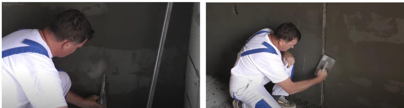
Рис. 11. Схема демонтажа маяков и заделки образовавшихся борозд
