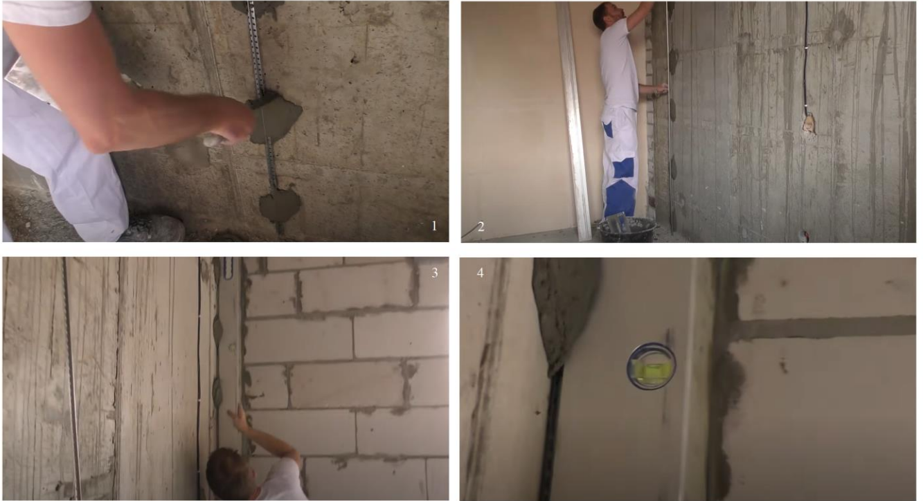
Рис.5. Монтаж маяка с помощью правила с уровнем
