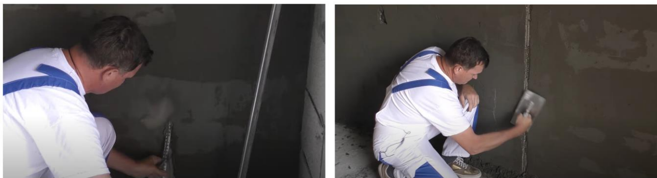
Рис. 17. Схема демонтажа маяков и заделки образовавшихся борозд
