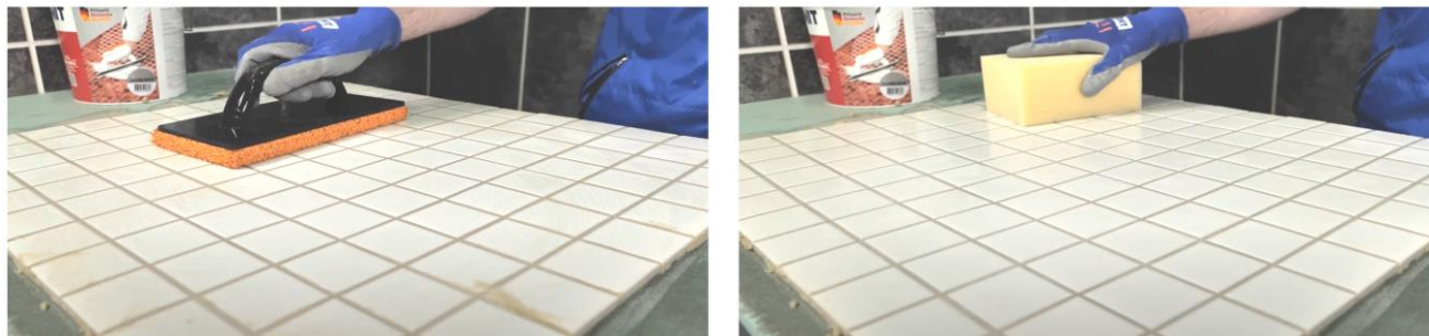
Рис. 22. Диагональными движениями шпателя убрать с поверхности плитки излишки затирки
