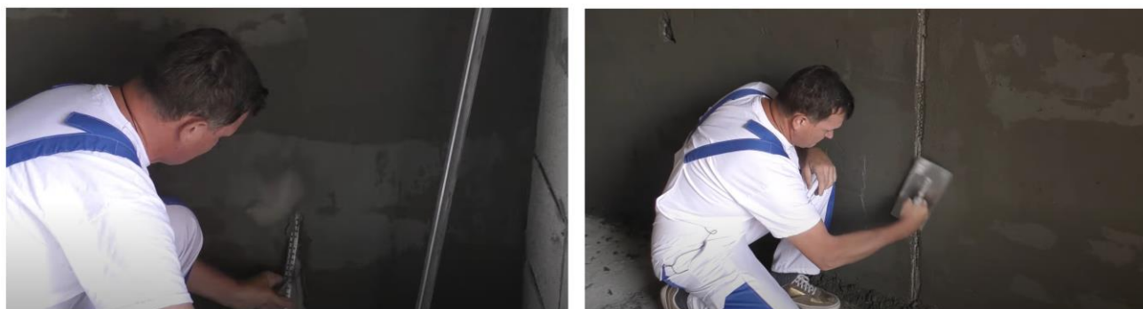
Рис. 21. Схема демонтажа маяков и заделки образовавшихся борозд
