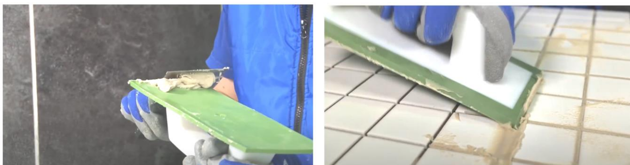
Рис. 42. Заполнение швов затиркой при помощи резинового шпателя
