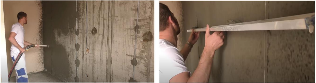
Рис. 27. Схема нанесения обрызга на поверхность и разравнивание правилами образовавшихся наплывов
