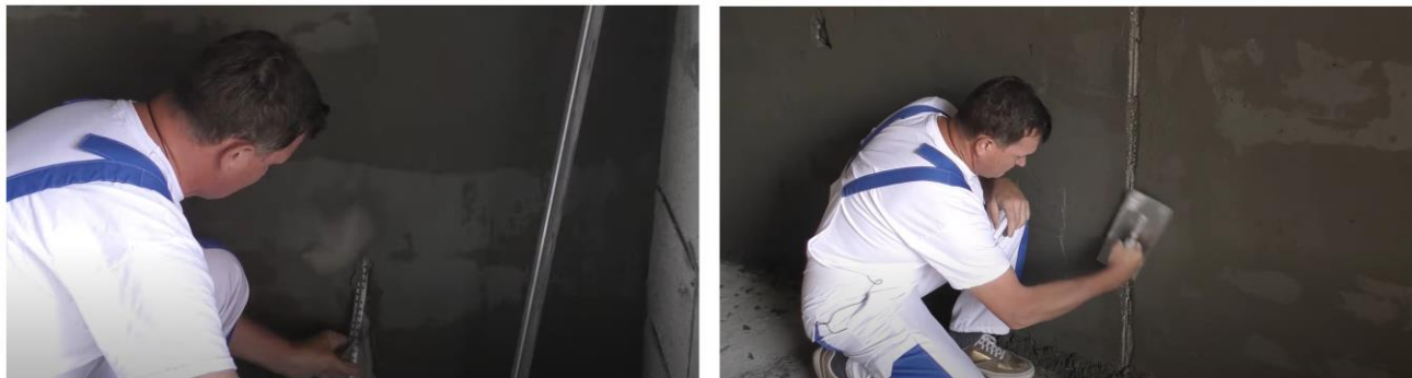
Рис. 29. Схема демонтажа маяков и заделки образовавшихся борозд
